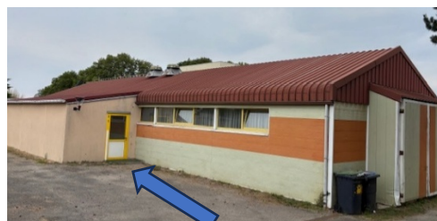
Maison des associations face à l'entrée de la MTL au-dessus du city stade
