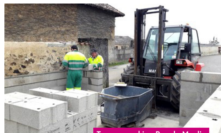
Travaux parking Puy du Moulin
