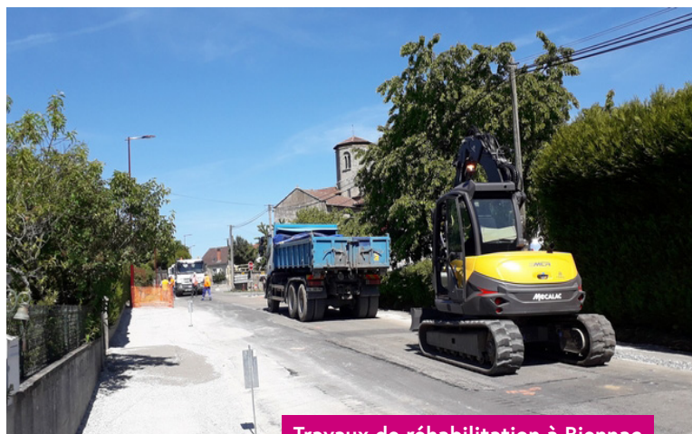
Travaux de réhabilitation à Biennac
