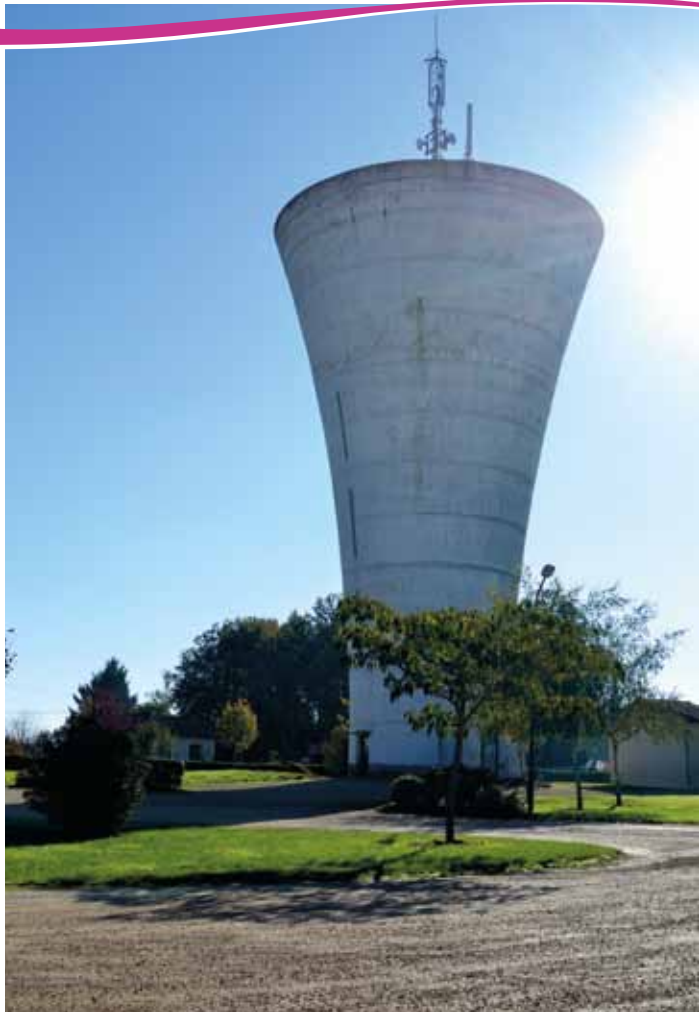
Le château d'eau
