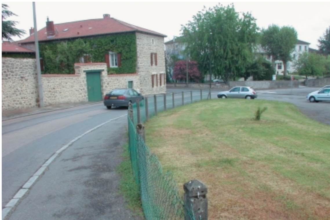
Au-dessus de la maison de retraite, ce virage étroit ne permet pas le croisement de deux camions sans que l'un chevauche le trottoir. Il sera élargi.
