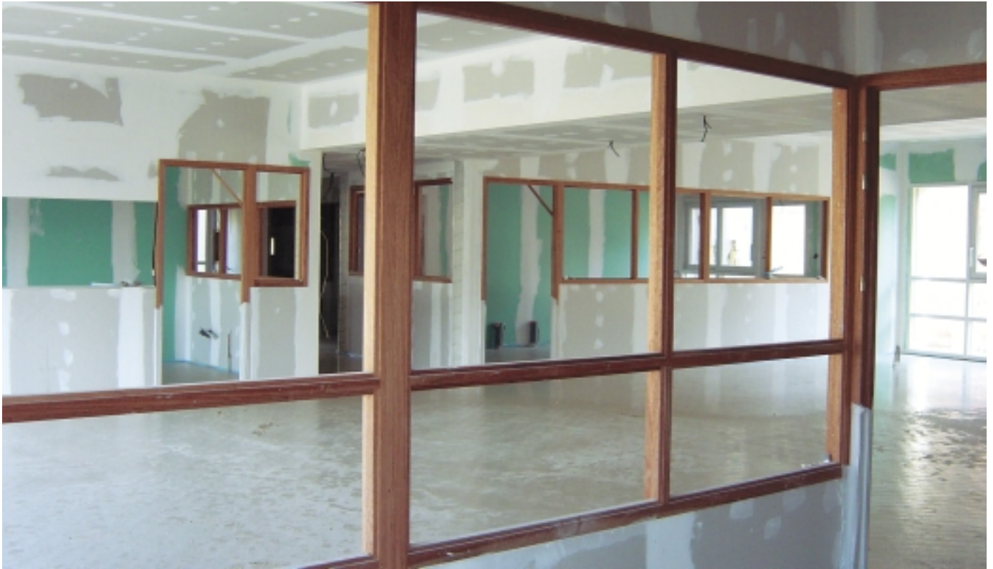
Vus de l'intérieur du bâtiment, les travaux en cours.
